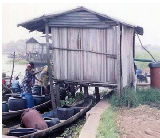
Pumpestationen i Ganvie (foto: Karl Aage Jørgensen)
