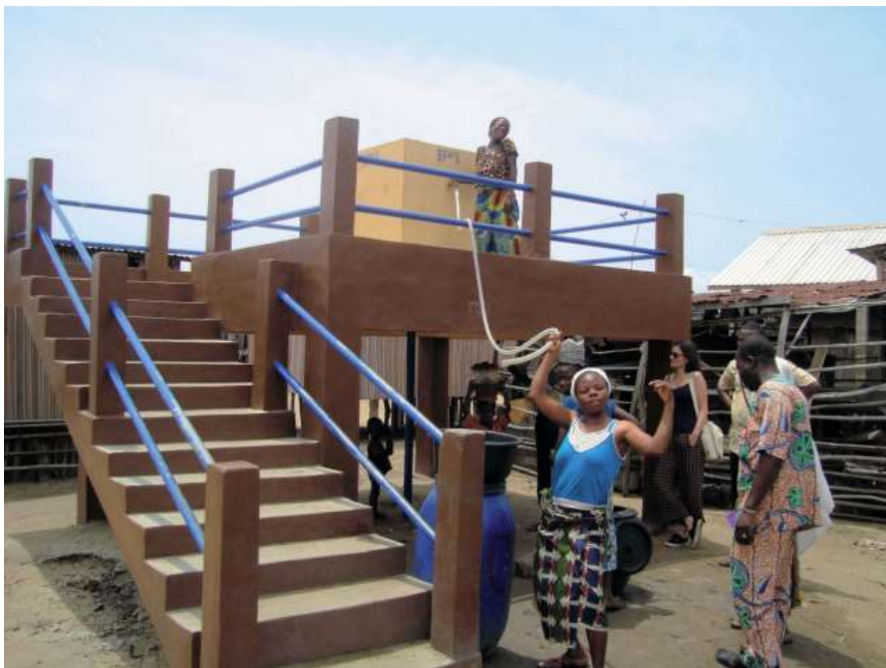
Et af vandforsyningsanlæggene ved Nokoué-søen.
