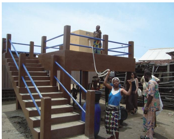
En af vandforsyningsinstallationerne.
