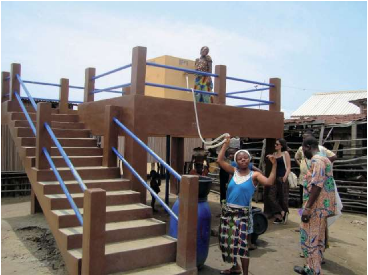
Et af vandforsyningsanlæggene ved Nokoué-søen.
